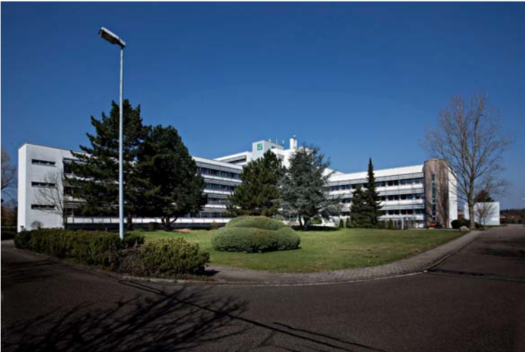
Das Fraunhofer-Institut für Optronik, Systemtechnik und Bildauswertung (IOSB) in Karlsruhe
